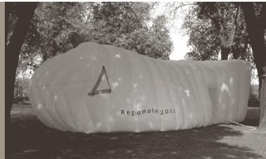
Personen schnell zu bewältigen. Ein Ventilator blies Luft zwischen zwei mit Bändern stabilisierten Nylon-schichten und innerhalb von fünf Minuten stand das vier mal sechs Meter große, drei Meter hohe Wahrzeichen der Regionale 2006 an der gewünschten Stelle. Wenn die Luft wieder raus war, passte das Ganze auch noch mühelos in den Kofferraum eines Pkws.
